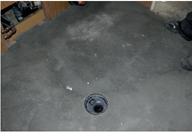
4. Lattian tasoitus ja uudet kaadot tehdään esim. Kiilto 70 Lattiamassalla.
