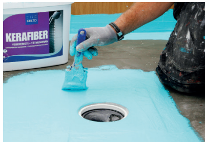
11. Käytettäessä lattiakaivovahvikeparia tehdään kiristysrenkaan asennus kun vedeneristys on valmis.
