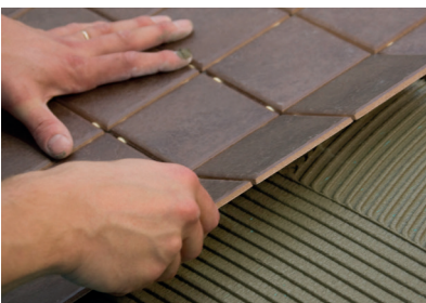
13. Lattialaatat kiinnitetään esim. Kiilto Saneerauslaastilla.
