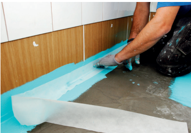
7. Nurkkavahvikenauha painetaan kiinni tuoreeseen vedeneristeeseen ja varmistetaan vahvikkeen läpivettyminen sivelemällä vedeneristettä myös nauhan päälle.
