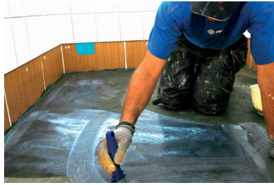
5. Kiilto Keraprimer levitetään kuivalle tasoitetulle lattialle 1:1 vedellä ohennettuna. Kuivuminen vähintään 1 tunti.
