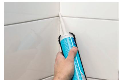
15. Ylimääräinen Lattiasaumalaasti puhdistetaan nurkista pois ja nurkat sekä läpiviennit saumataan Kiilto Saniteettisilikonilla. Valmis märkätila voidaan ottaa käyttöön seuraavana päivänä, mutta mahdollinen lattialämmitys voidaan kytkeä päälle asteittain n. 1 viikon kuluttua saumauksesta.
